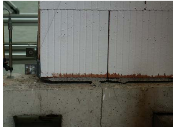
Bild 5: Prüfkörper aus HLzB8-0,6, Wandlänge 1,00 m, Auflast 30 kN, Detail (klaffende Fuge am Wandfuß) während des Versuchs bei maximaler Horizontalverschiebung
