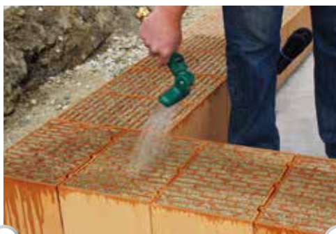
1 Ziegelreihe befeuchten
