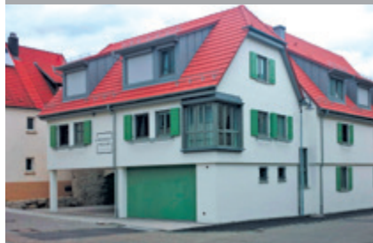
Landhotel in Hessigheim gebaut mit Unipor WS09 Coriso.
