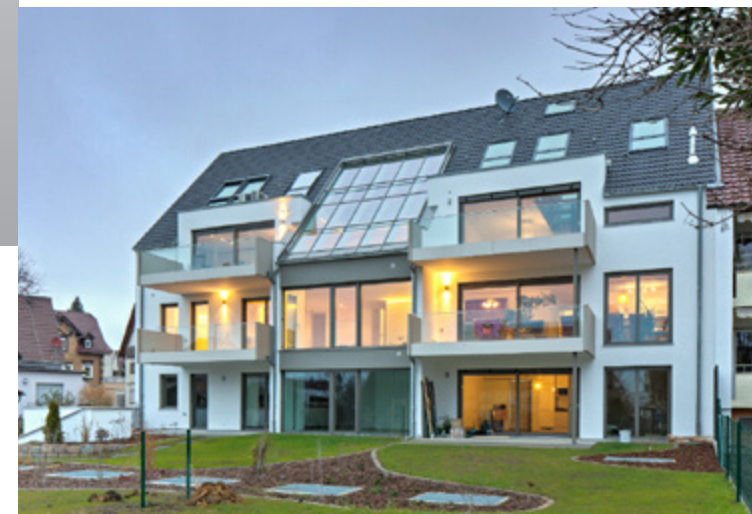
Mehrfamilienhaus in Stuttgart-Degerloch gebaut mit Unipor WS08 Coriso.
